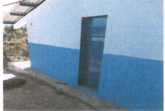
Foto 2: mantenimiento a estructura de puerta, (lijado y aplicación de pintura)
