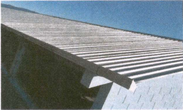
Foto1: Sustitucion de lámina, por lámina troquelada aluzinc calibre 26
