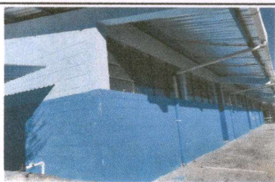
Foto 6: Pintura en muro exterior
