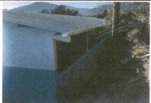
Foto 4: Sustitución de canal de pvc para agua pluvial
