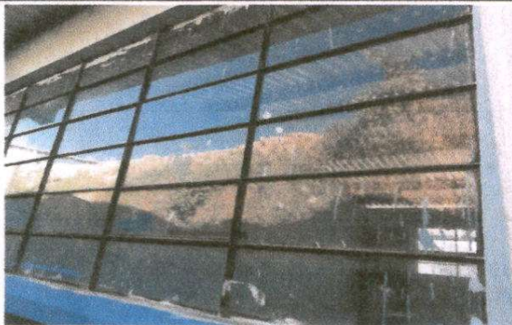
Foto 3: sustitución de vidrios
