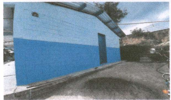
Foto 6: pintura muro exterior
