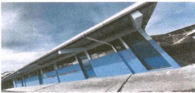
Foto 5: mantenimiento a estructura de puertaS (lijado y pintura)
