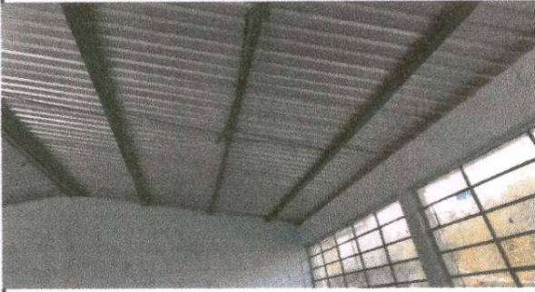
Foto1: mantenimiento a estructura de soporte de metal
