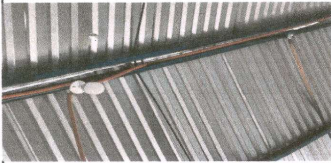
Foto 3: reparación de sistema electrico
