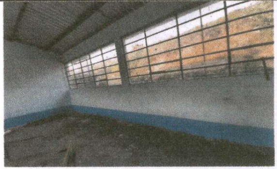
Foto 2: pintura en muro interior
