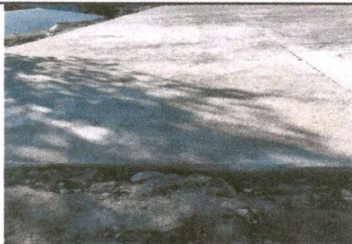
Foto 5: Reparación de piso de torta de concreto
